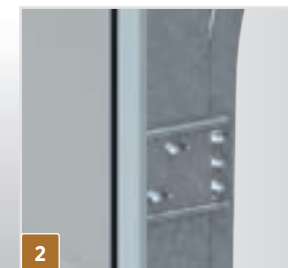
Skręcane prowadnice z ościeżnicą
