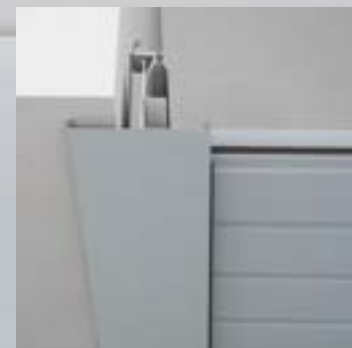
Montaż w otworze - maskownica przed otworem
