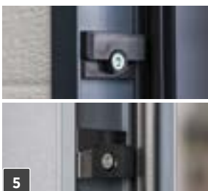
5 System zapobiegający opadnięciu skrzydła.
